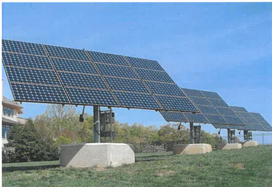
Fig.11 – Model sistem fixare panouri fotovoltaice cu urmărire solară (tracker solar) pe două axe 16 panouri fotovoltaice
